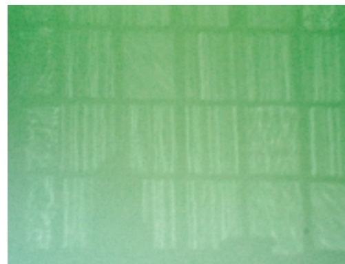
De verticale trekstrepen in getrokken glas zijn goed zichtbaar in de reflectie van een raam op een muur. Naast getrokken glas bevat dit raam ook enkele ruitjes geblazen glas, herkenbaar aan de wat wollige reflectie
