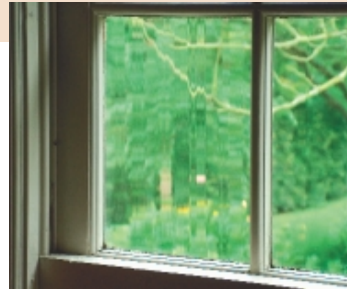
Dit raam bevat getrokken glas met sterk gepro- nonceerde trekstrepen, waardoor, onder een bepaalde hoek, een erg vertekend beeld ontstaat
