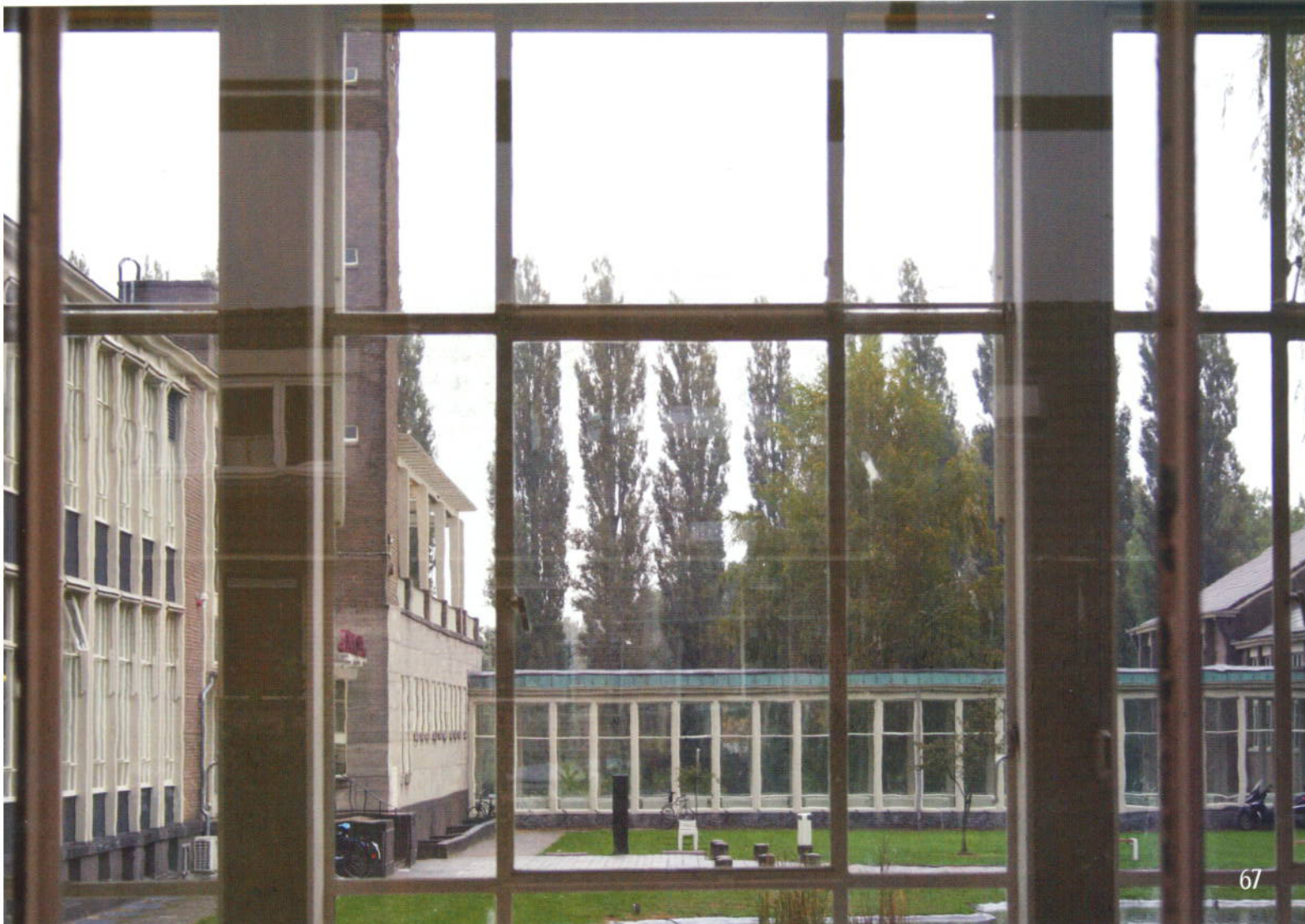
Het isolerende enkelglas in bestaande stalen vensters. Cultuur-, architectuur en materiaalbehoud. Levensduur en terugverdiendtijd in positieve balans.
