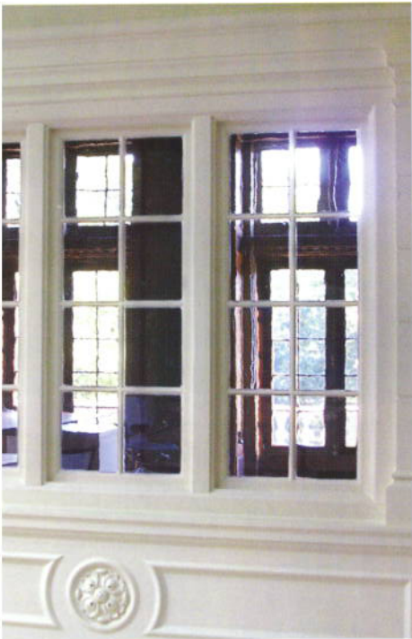
isolerende enkelglas in bestaande houten vensters.
