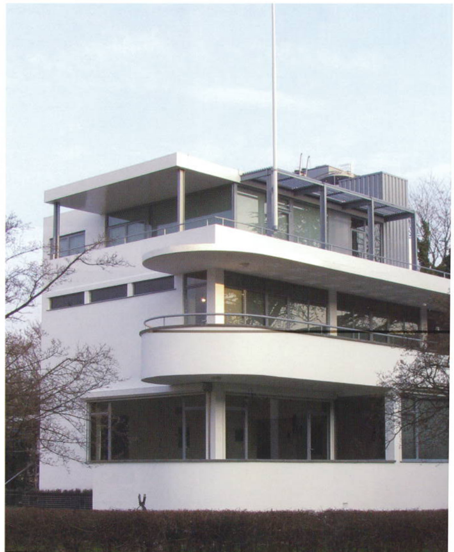
Het isolerende enkelglas in stalen vensters uit 1938.
